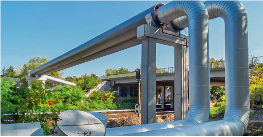
SPEZIALLEISTUNG Rohrbrücke nach Fertigstellung
