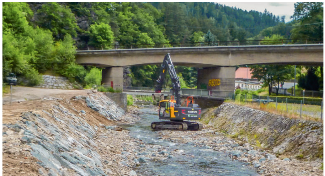
AN DER MÜGLITZ Profilierung des Ge- wässerabschnittes
