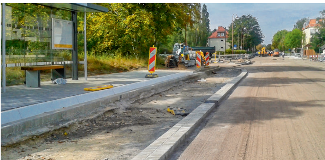
BARRIEREFREIHEIT Bushaltestelle im Bauzustand
